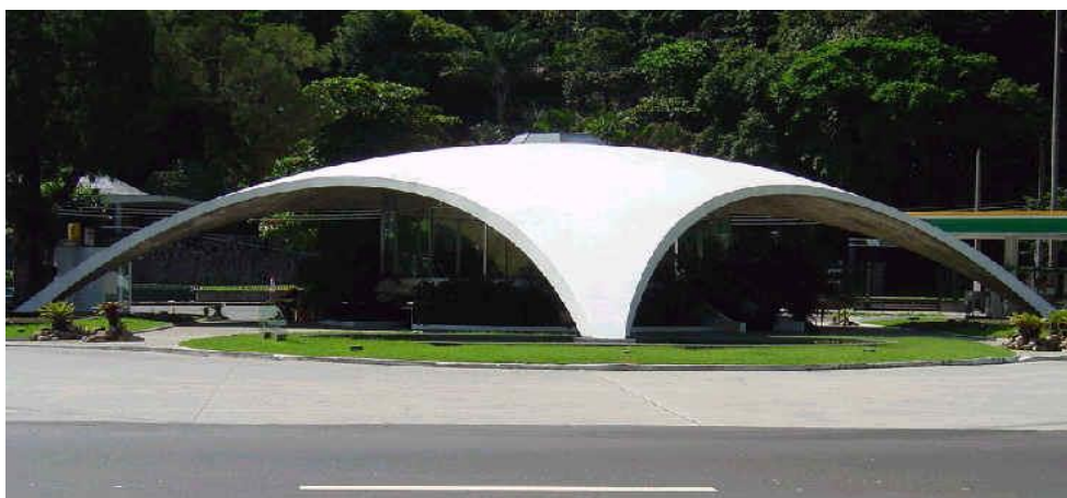
Figura 14 - Exemplo de cobertura em casca de concreto apoiada em 4 pontos localizada no Rio de Janeiro.
